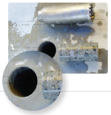
1- Utilizar el punzón guía al iniciar el taladro. 2- Extraemos el punzón cuando la corona haya penetrado levemente.
